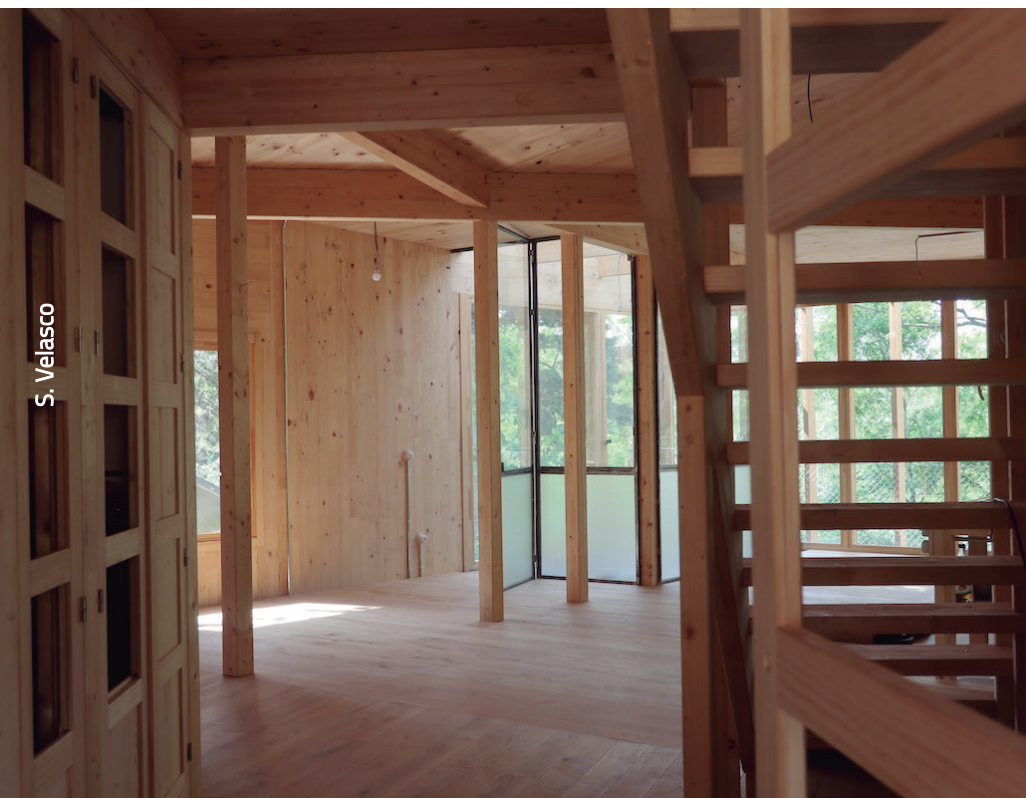
Imagen 3. Obra acabada. Espacio interior continuo en toda la vivienda, con invernadero al fondo. Interior en madera de CLT estructural que se deja vista, e instalaciones vistas. Vivienda unifamiliar en Mataalpino (Madrid)
