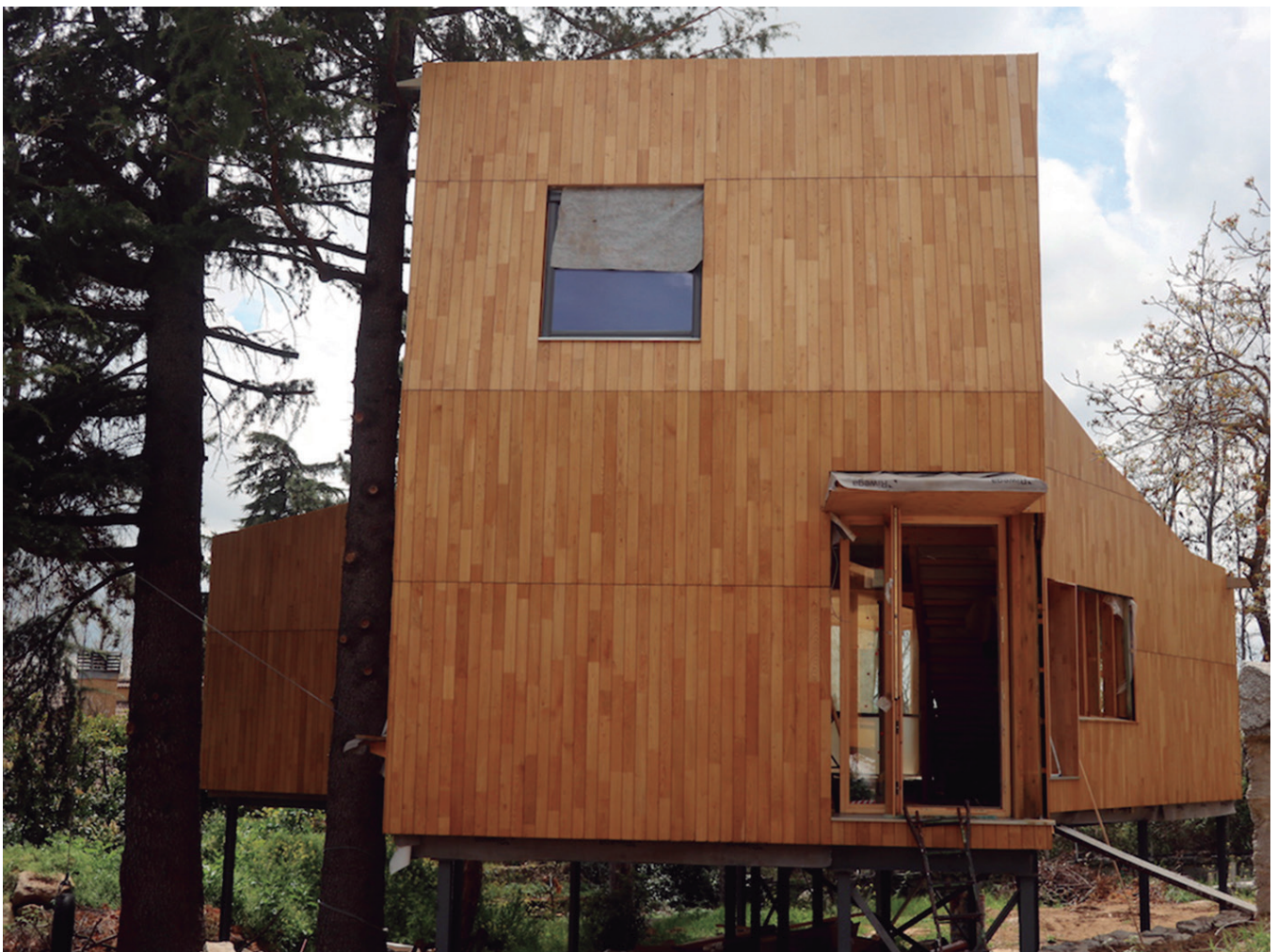
Imagen 4. Zona de acceso a la vivienda. Fachada ventilada acabada con entablado de madera de castaño sobre rastreles. Mataelpino (Madrid)
