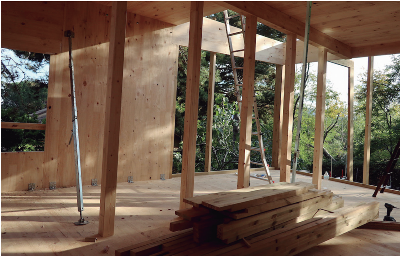
Imagen 1. Construcción con madera de una vivienda unifamiliar en la sierra de Madrid (Mataelpino). Zona del salón y el invernadero. Montaje de los muros portantes de CLT. Segundo día de montaje
